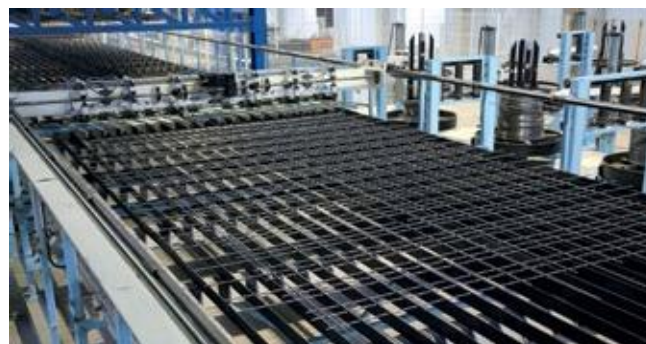
Вывод сваренной панели от сварочного портала, АWM
