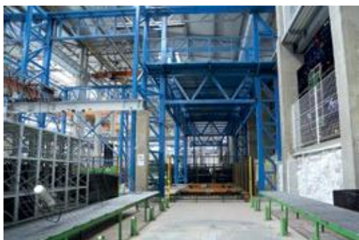
Буфер для сеток и зона выгрузки сеток автоматическим краном на линию формовки трехслойных панелей, АWM
